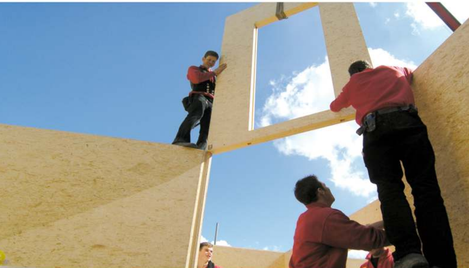
en gennemtænkt stablings rækkefølge muliggør den hurtige montering
